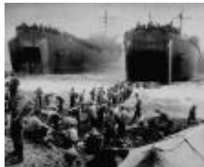
Dos LST abren sus gigantescas compuertas en la isla de Leyte mientras que los soldados construyen los embarcaderos con bolsas de arena para hacer rampas y así poder acelerar las operaciones de descarga, 1944.
