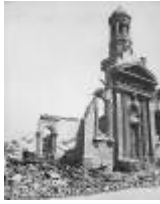
Un edificio totalmente en ruinas después de los incesantes bombardeos que cayeron en Londres. Abril de 1941.
