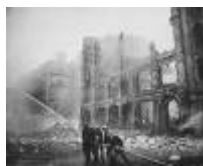
Bomberos trabajan en la extinción del fuego, provocado por una bomba después de un ataque nocturno, Londres, 1941.
